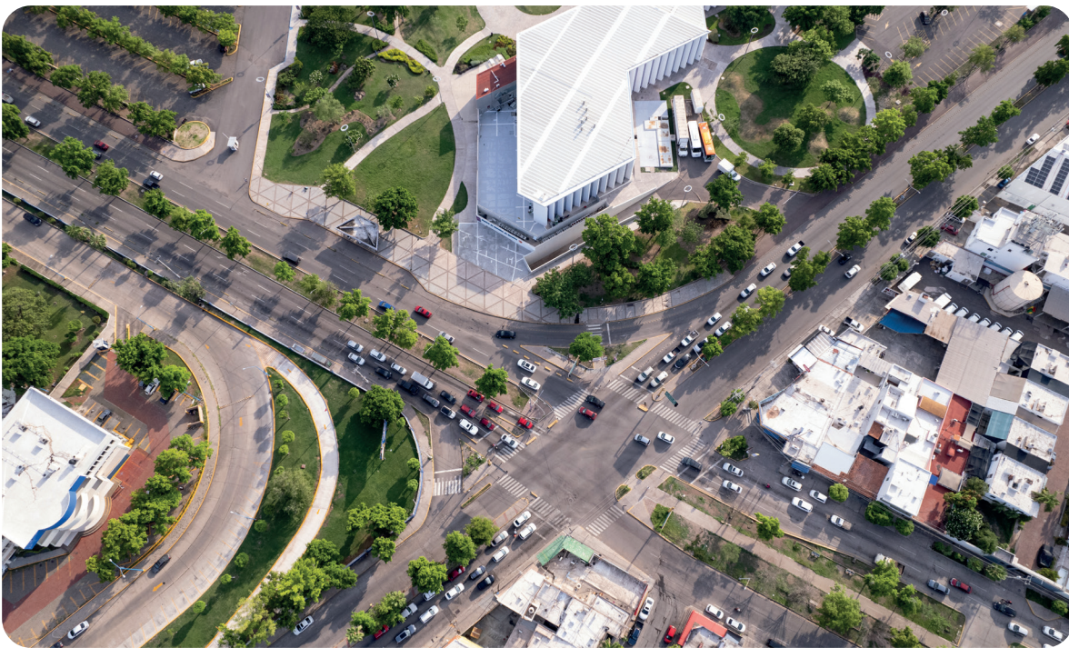
Crucero avenida Universitarios y calzada de Las Américas.
