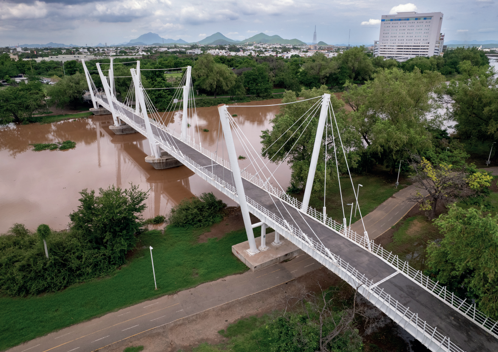
Puente Bimodal Norte, Culiacán, Sinaloa.
